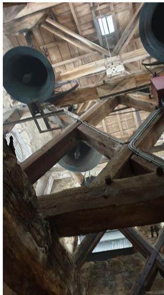
En 1954 la charpente du clocher a été refaite. À cette occasion, le petit clocheton a disparu et a été remplacé par une croix en fer forgé.
