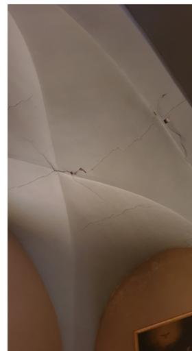
De longues fissures apparaissent sur les voûtes et les murs côté Est et Ouest. Après de nombreuses études sur les causes, une liste de travaux est arrêtée.
